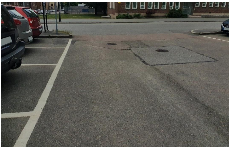
Figur 7. Dagvattenbrunnar som avvattnar parkeringen vid Ernst Fontells plats.
